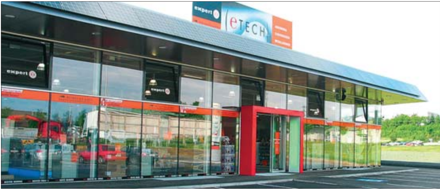
In der neuen, hochmodern ausgestatteten Filiale von ETECH in Rohrbach findet man auf 1.750 m 2 Geschäftsfläche alles rund um Elektro.
